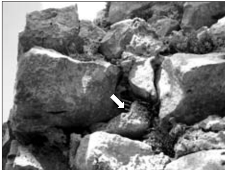
Fig. 87 Frammento di tegola all'interno del muro
