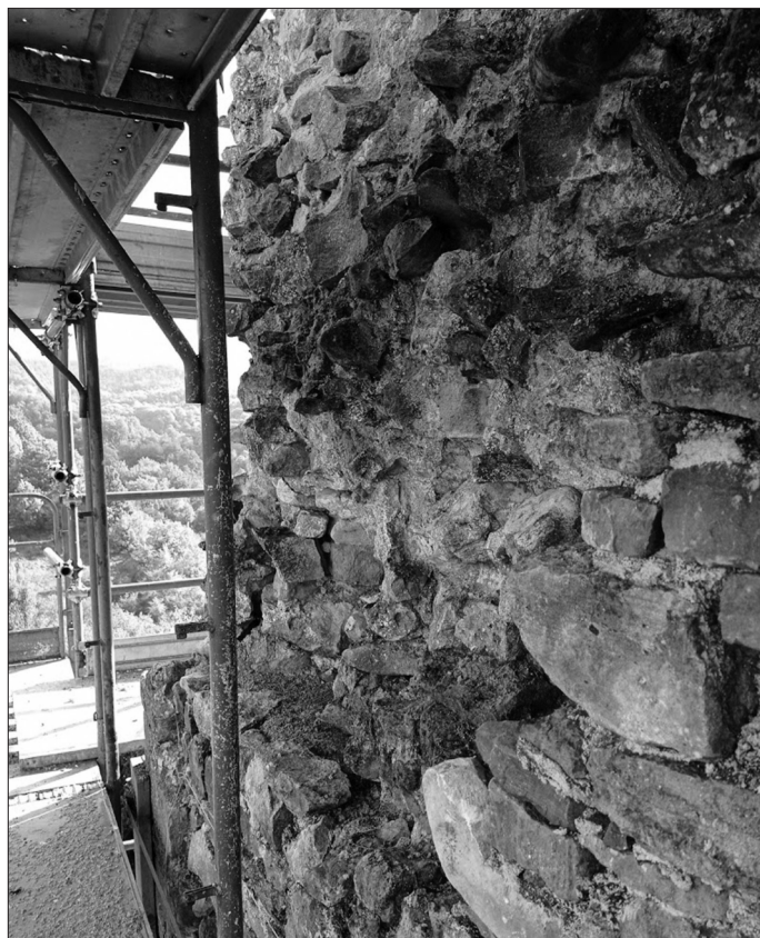
Figg. 4/5. Torre, fronte nord: lacuna del paramento emersa dopo la rimozione della vegetazione infestante.
