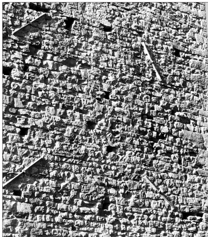
Fig. 9. Torre post-intervento: copochiave fronte est.
