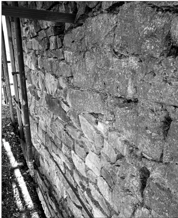
Fig. 7. Torre, ricostruzione del paramento lacuna fronte nord.
