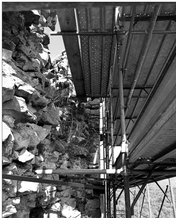
Figg. 4/5. Torre, fronte nord: lacuna del paramento emersa dopo la rimozione della vegetazione infestante.
