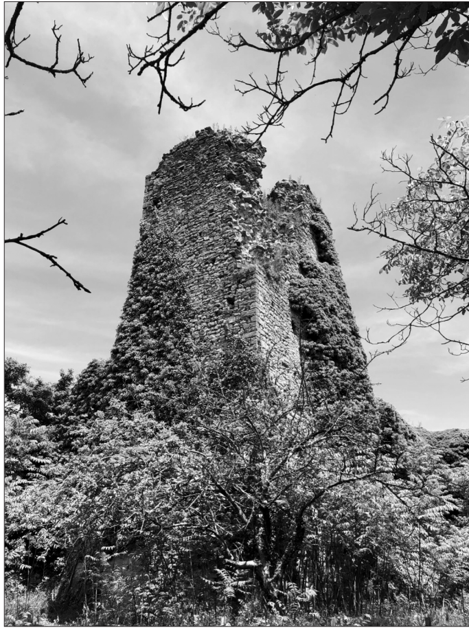
Fig. 2. Colle Sant'Angelo di Carsoli. La torre centrale del recinto castrale sommitale prima dell'intervento di restauro.
