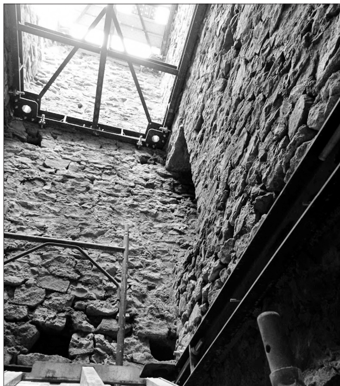
Fig. 8. Torre, canna interna: montaggio delle cerchiature metalliche.
