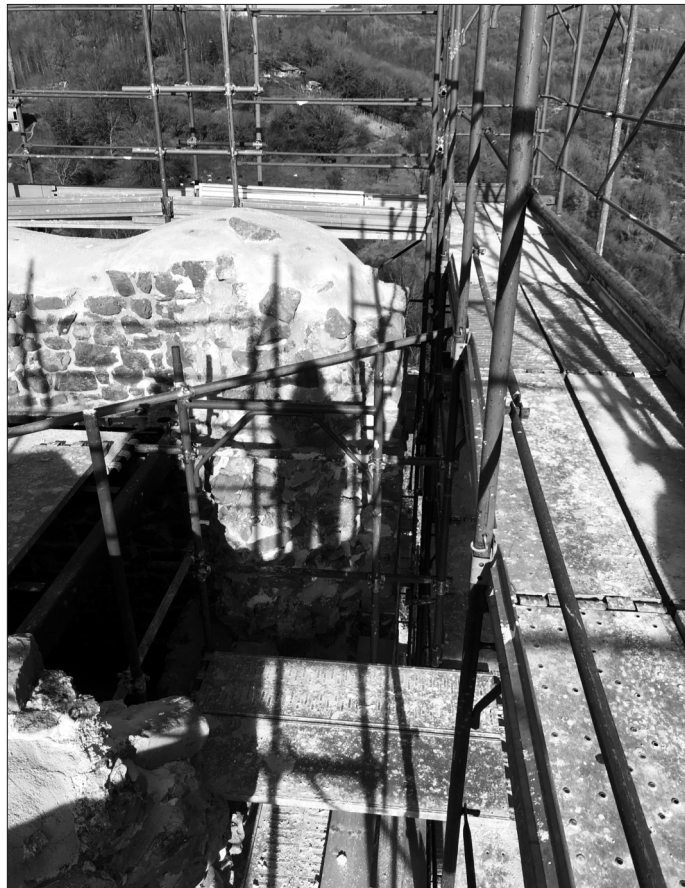
Fig. 6. Torre, trattamento delle creste sommitali.
