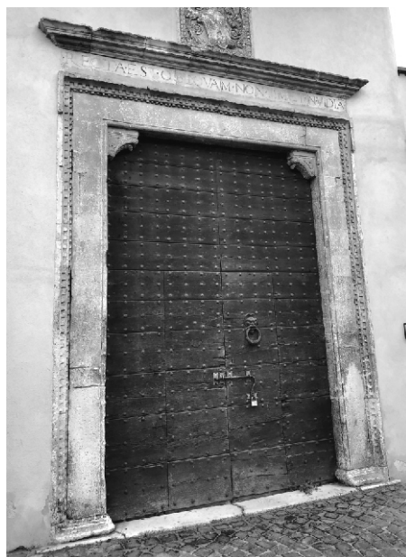
Fig. 13. Tagliacozzo, Palazzo Orsini, Portale di accesso al cortile
